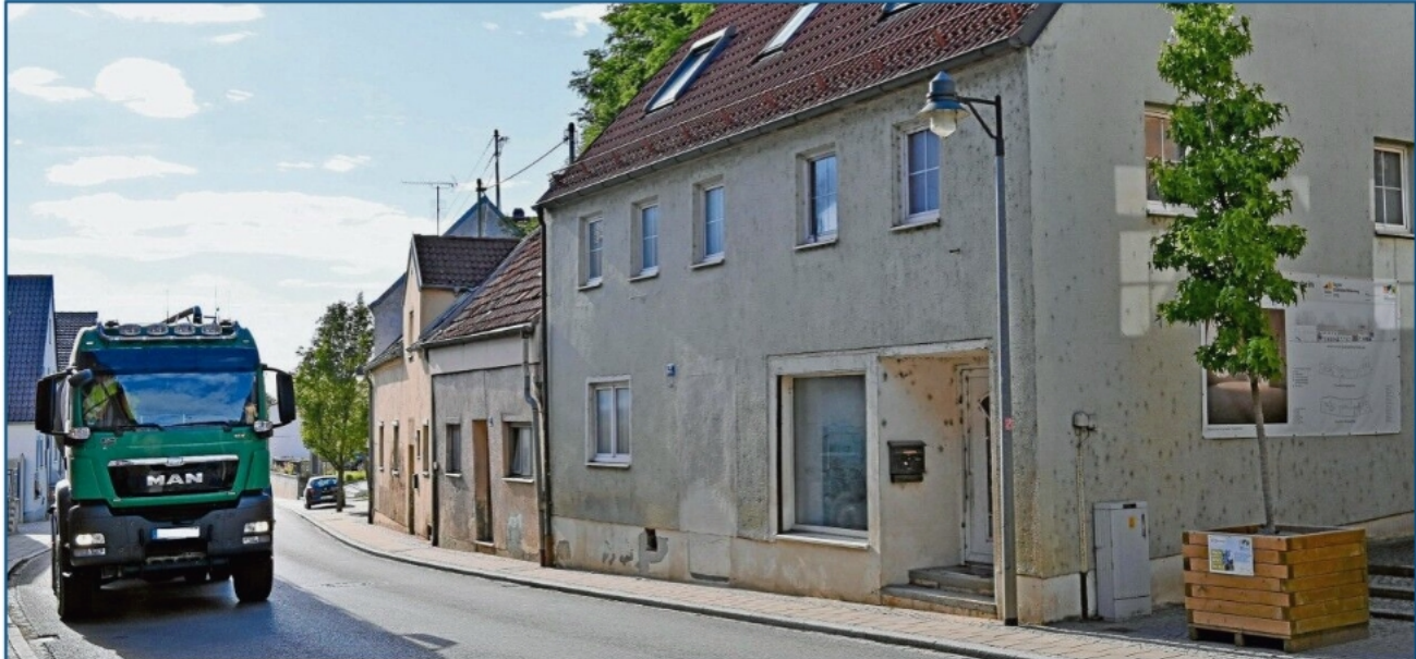
An dieser Stelle an der Donauwörther Straße entsteht das neue Kulturzentrum Burgheims. Die Häuser sollen saniert oder abgerissen und später miteinander verbunden werden. Foto: Reinhard Köchl
