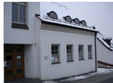
Gebäude der Sozialstation
